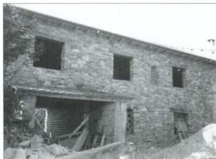
Fachada del refugio reconstruida al estilo de la arquitectura tradicional de la zona. (Foto. A. Morán)
