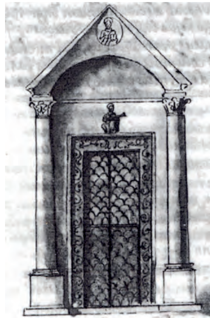
Fig. 9 : Portail central du vestibule avec la statue de saint Pierre, vers 1300, ancienne basilique Saint-Pierre du Vatican. Dessin du XVII e siècle.
