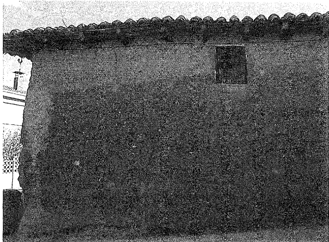
RABANAL DEL CAMINO, fábrica de tapial visto.
