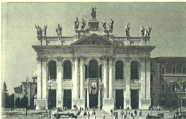
San Juan de Letrán: la fachada principal
