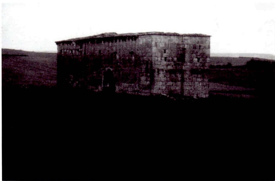
1991. San Nicolás prima dell'inizio dei lavori.
