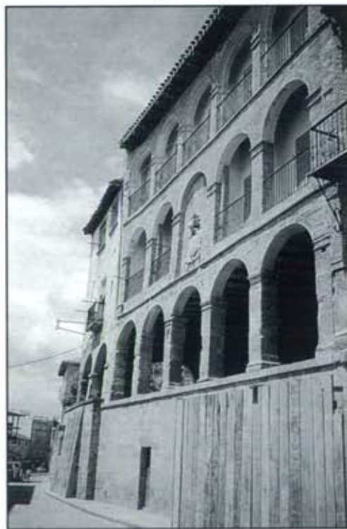
Navarrete. Casona en la calle de la Cruz.
