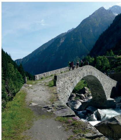
Hädlerinsbrücke in der Schöllenen
