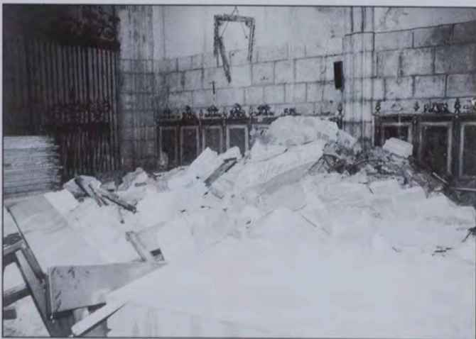
MATERIAL DEL DERRUMBAMIENTO DE LA CAPILLA DE SAN NICOLÁS, EN SAN JUAN DE ORTEGA, BURGOS.
