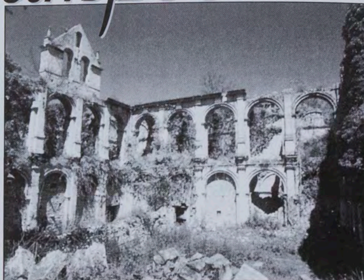
EXTERIOR DEL CLAUSTRO DEL MONASTERIO DE RÍOSECO.
