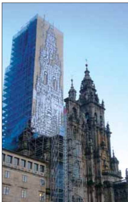
La torre norte rodeada de andamios. Mario Clavell
