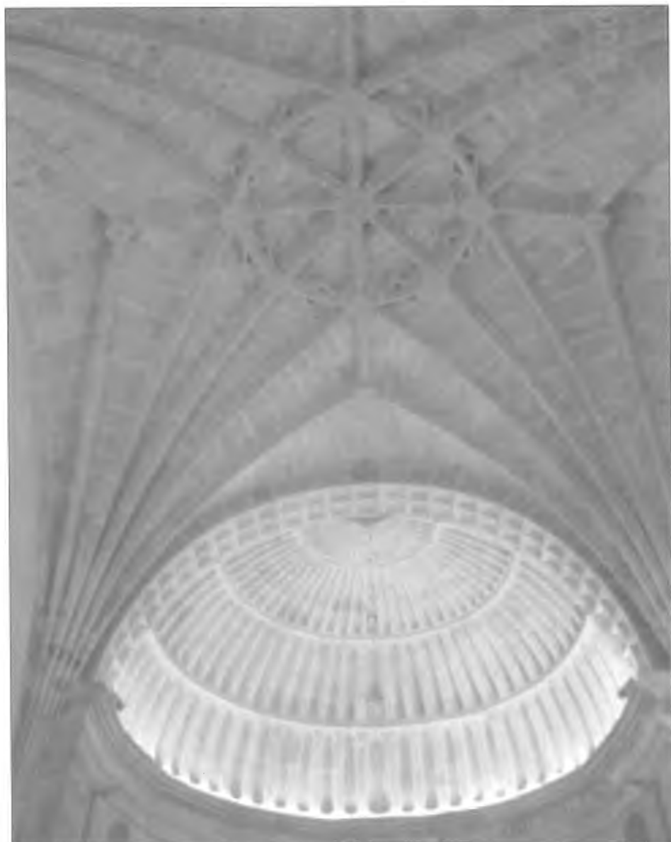
Primer tramo de la bóveda y casacarán de la iglesia de Castillo.
