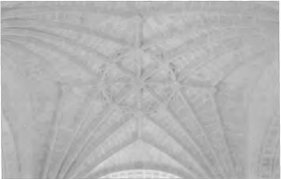
Dos aspectos de las cruceiras de las bóvedas, fabricadas con elementos reaprovechados de la vieja iglesia medieval de San Pedro de Castillo.
