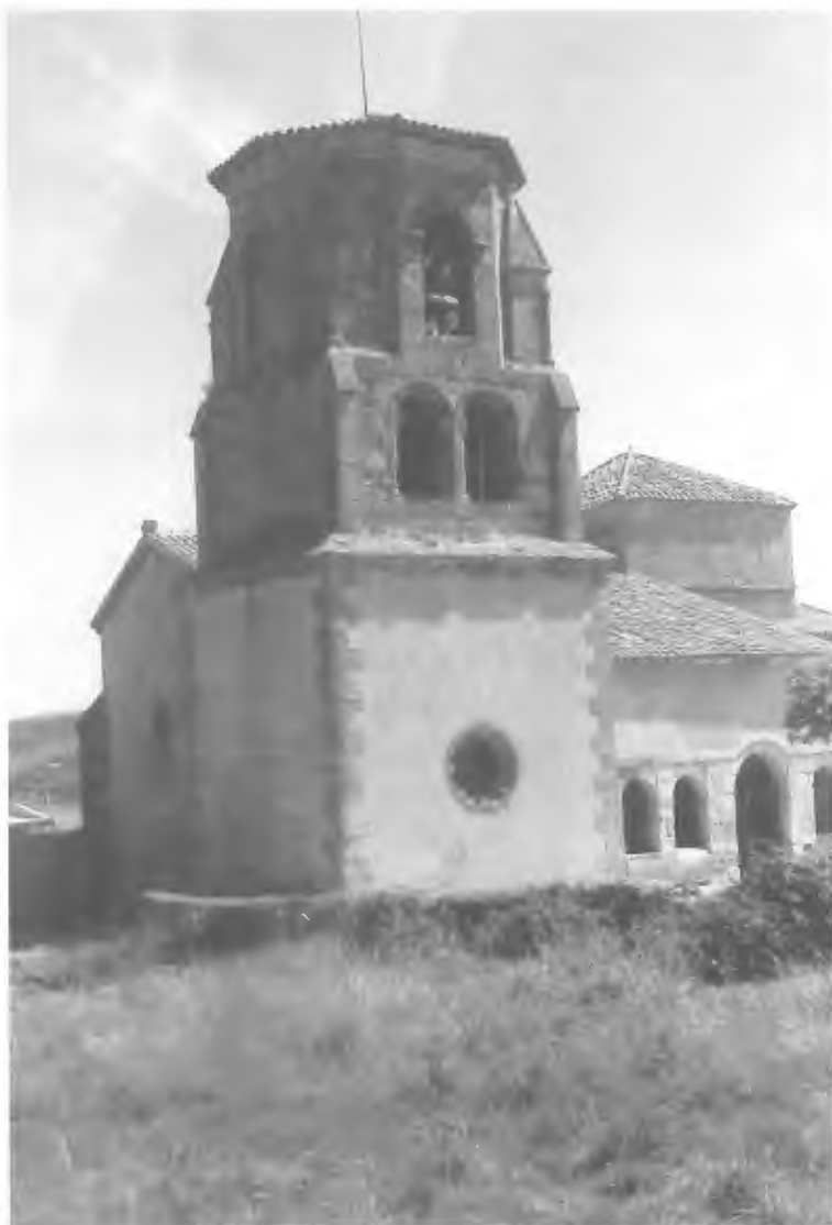
Fachadas oeste y sur de la iglesia de Bareyo en la actualidad.
