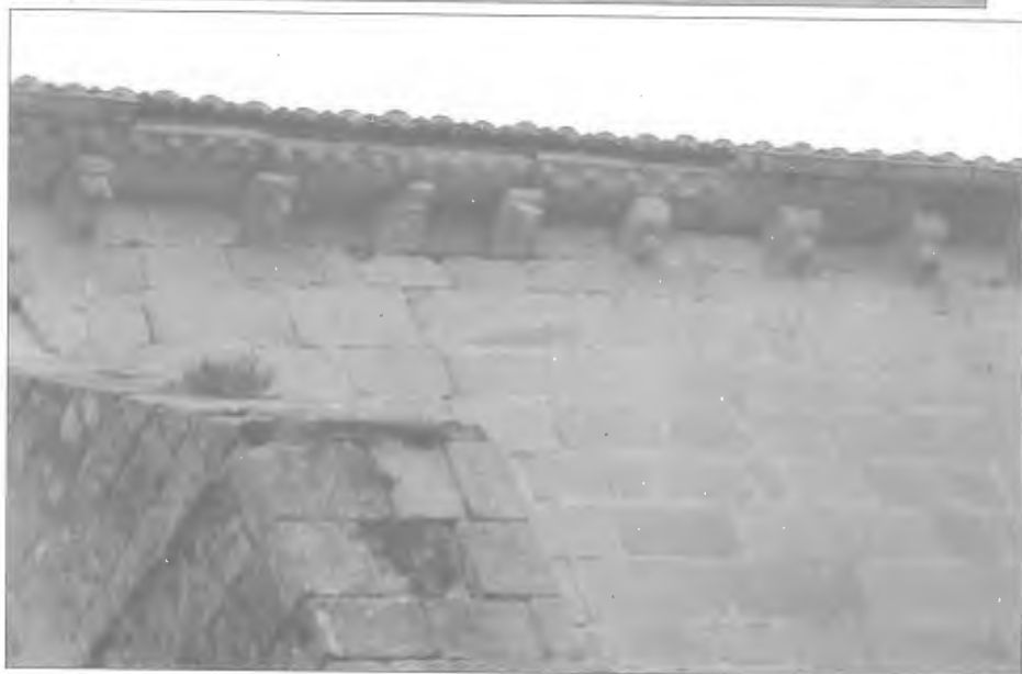
Canecillos reaprovechados en la fábrica actual, procedentes de la vieja iglesia románica de San Pedro de Castillo.
