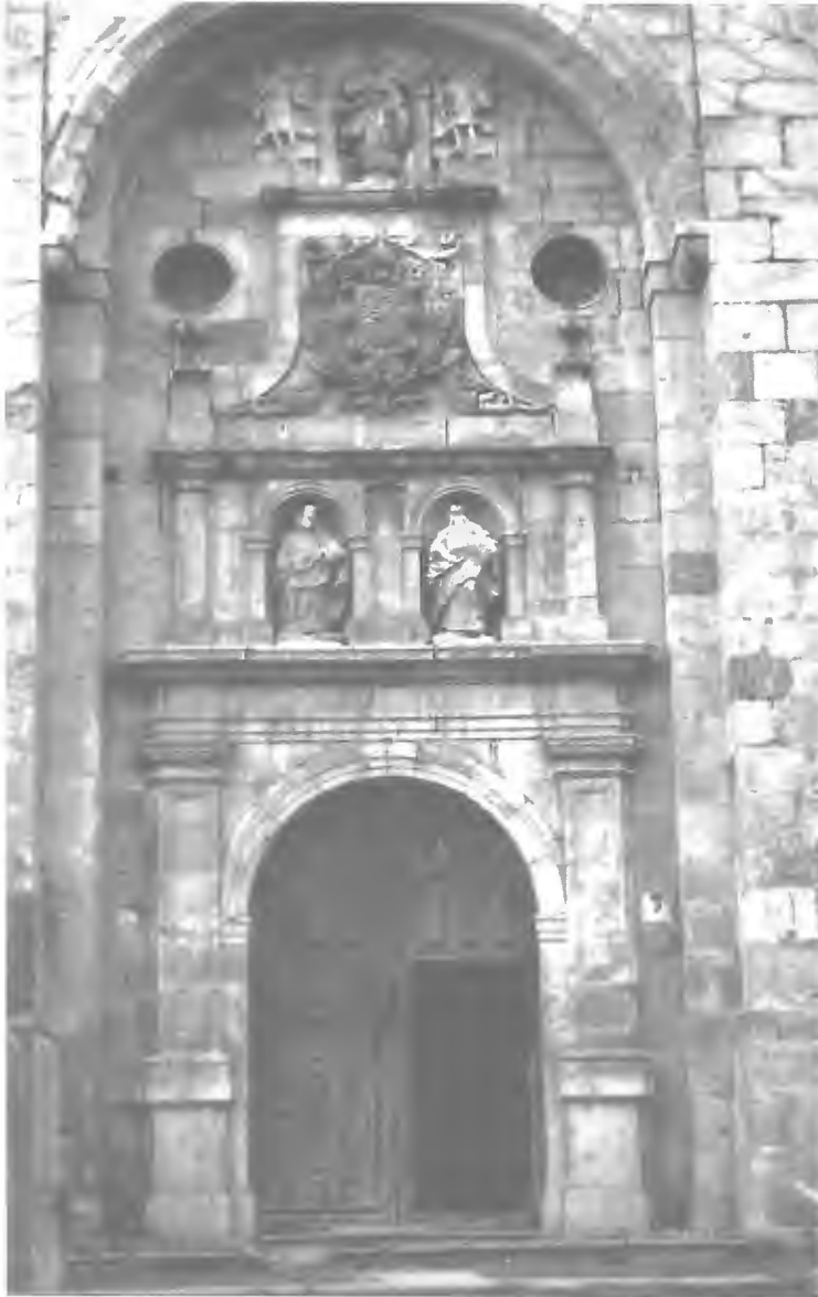
Portada de la iglesia de Isla en 1958 (Foto Archivo CEM). Construido por Francisco del Pontón Setién y Barnabé de Hazas hacia 1690.
