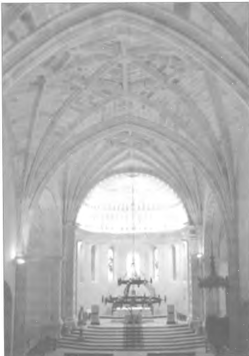
Aspecto de la nave y el presbiterio de la iglesia de San Pedro de Castillo.
