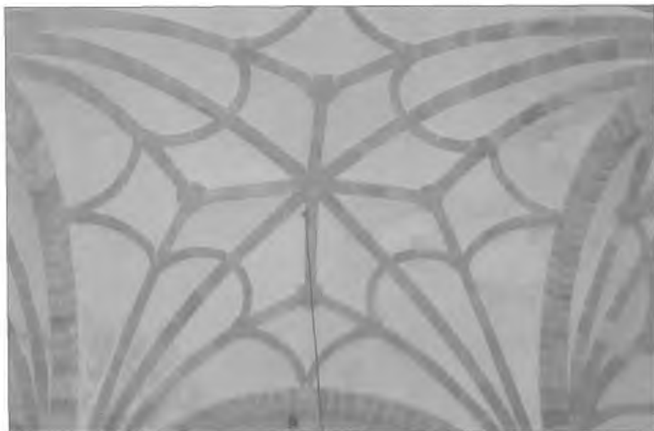
Bóveda de la nave laterales y de la nave central.
