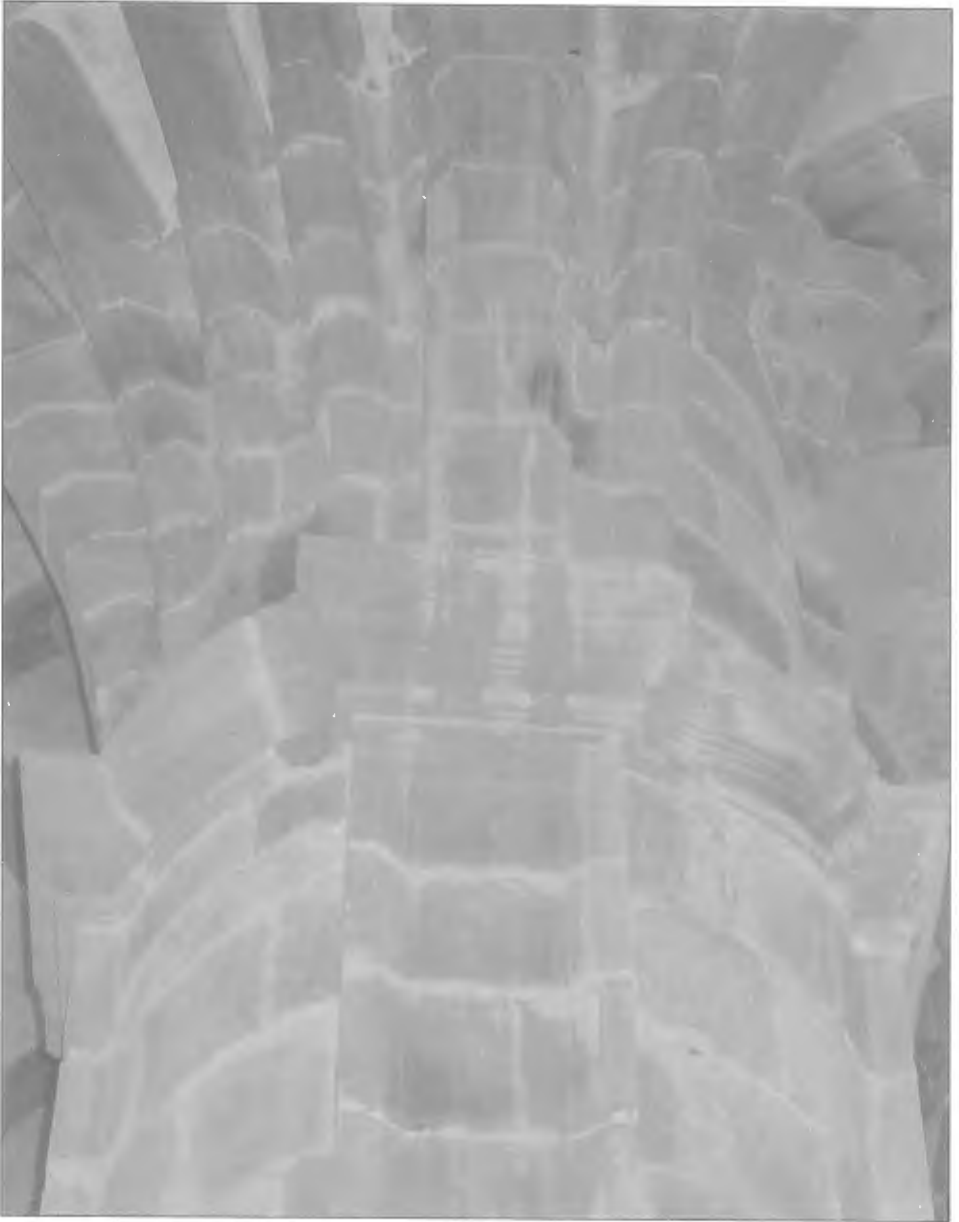
Arranque de las crucerías de las bóvedas.
