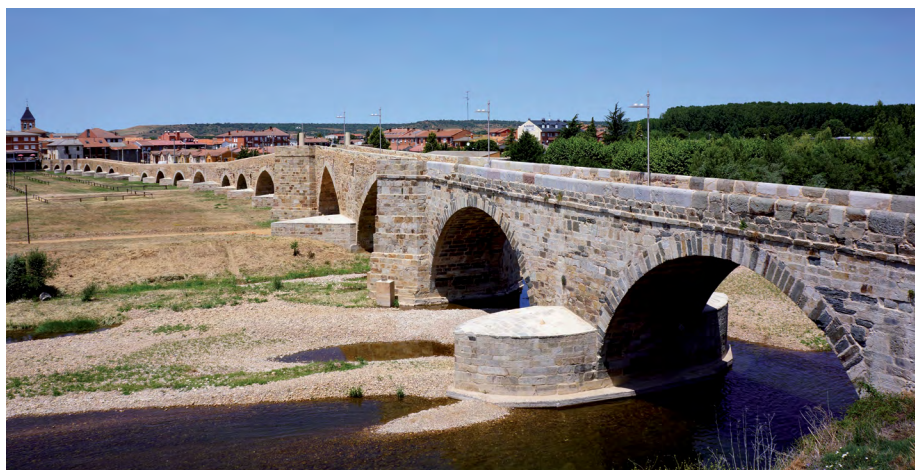
Figura 11. Hospital de Órbigo, con toponimia del Camino, con el puente medieval. El río va mermado por la regulación de un gran embalse y la campaña de regadío estival. (Foto: C. Cascos, 23/06/2013).
