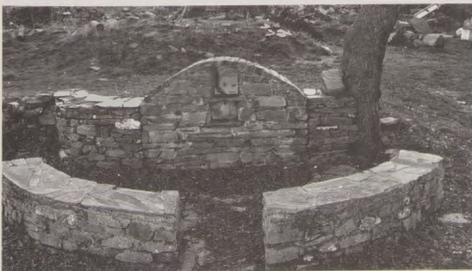
Foto 6: Fuente nueva de piedra en el complejo de "Taberna de Gaia"
