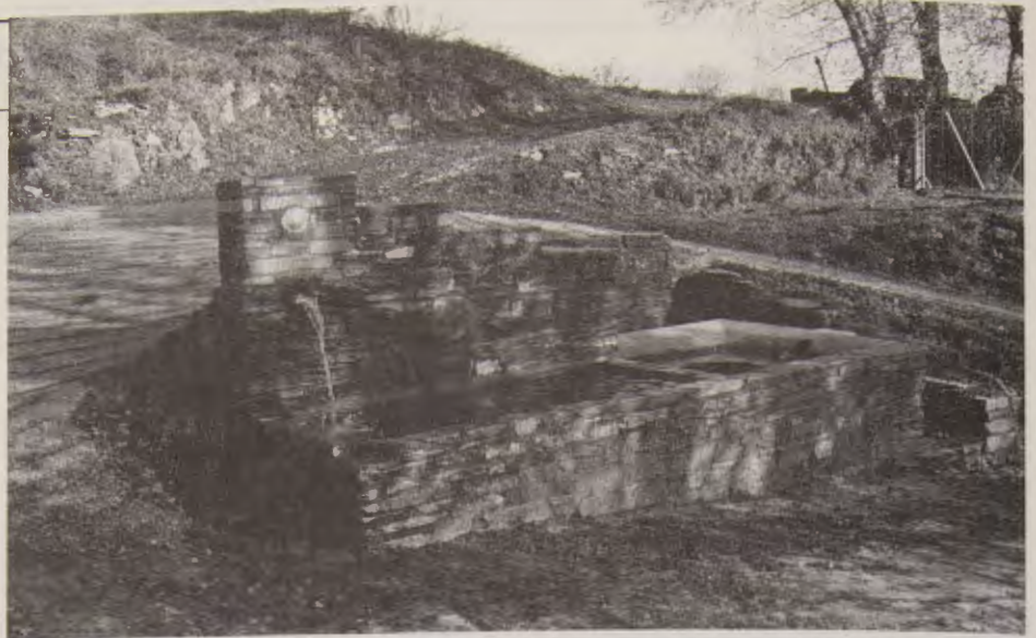
Foto 72: Fuente de piedra de Laguna de Castilla, la última de las fuentes que encuentra el peregrino a su paso por El Bierzo
