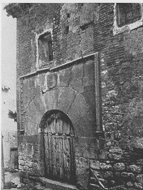
Fachada del hospital
