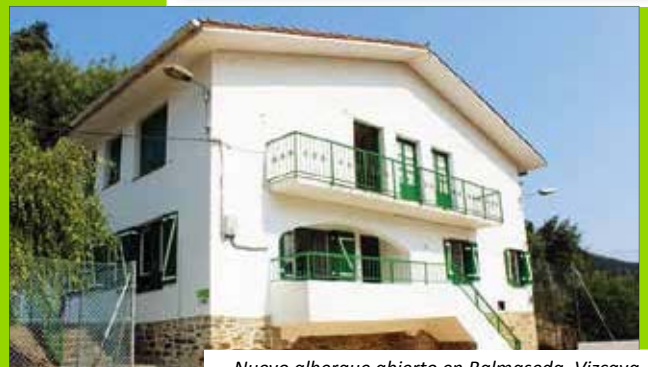
Nuevo albergue abierto en Balmaseda. Vizcaya
