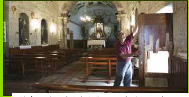
El párroco de la iglesia de Sigrás muestra los destrozos de la puerta
