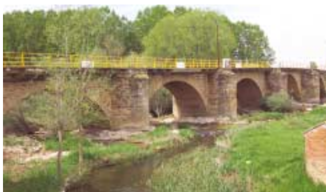
Fig. 4. Camino Real de La Bañeza a Valderas. Puente de Cebrones del Río.
