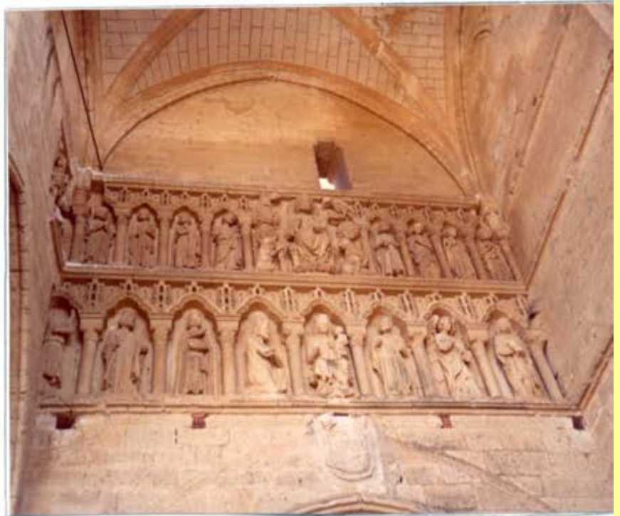
Parte de fachada de la iglesia de Santa María. Villasirga.
