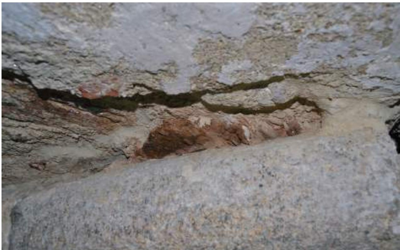
**Figura 6.** Restos de tabla de roble del encofrado con el que se construyeron los plementos.
