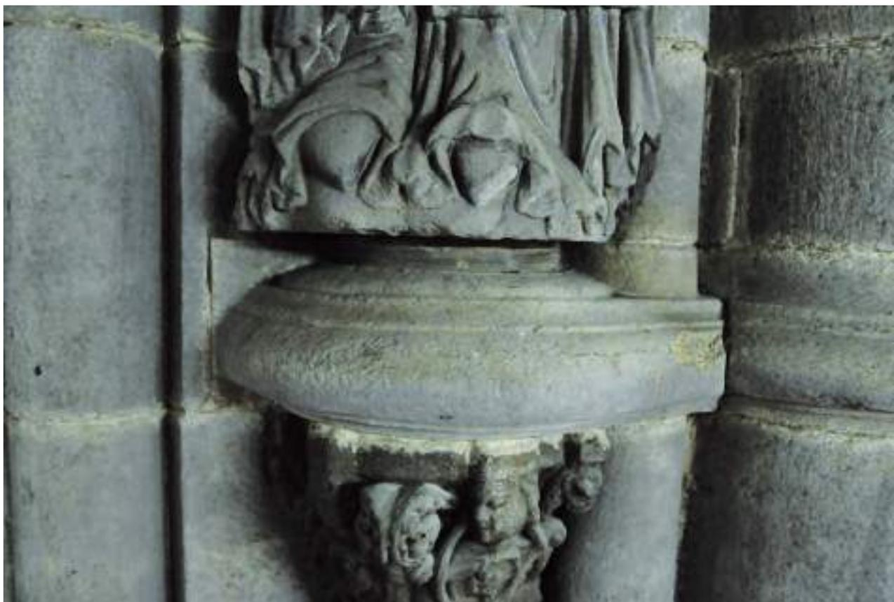
**Figura 7.** Catedral de Santiago de Compostela. Reverso de la fachada del Obradoiro, soporte sur. Detalle de la imposta que sirve de soporte a la estatua-columna de la reina de Saba.
