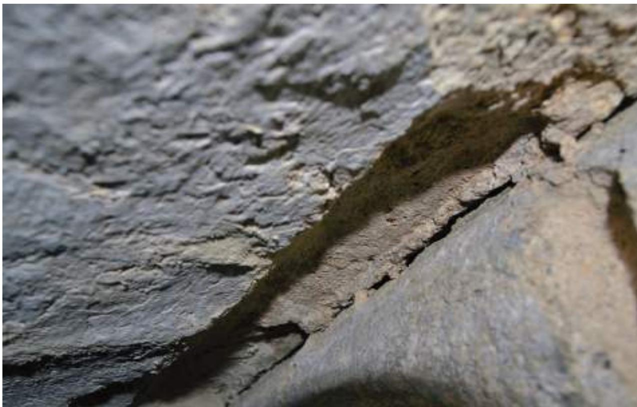
**Figura 2.** Foto de la impronta dejada en el mortero por la madera empleada como cimbra constructiva de los plementos.
