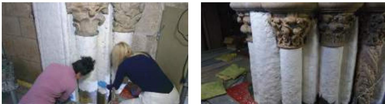
**Figuras 29 y 30.** Segunda extracción-aplicación de papeta de celulosa. Zona PT3 JB03, JB04 y jamba.
