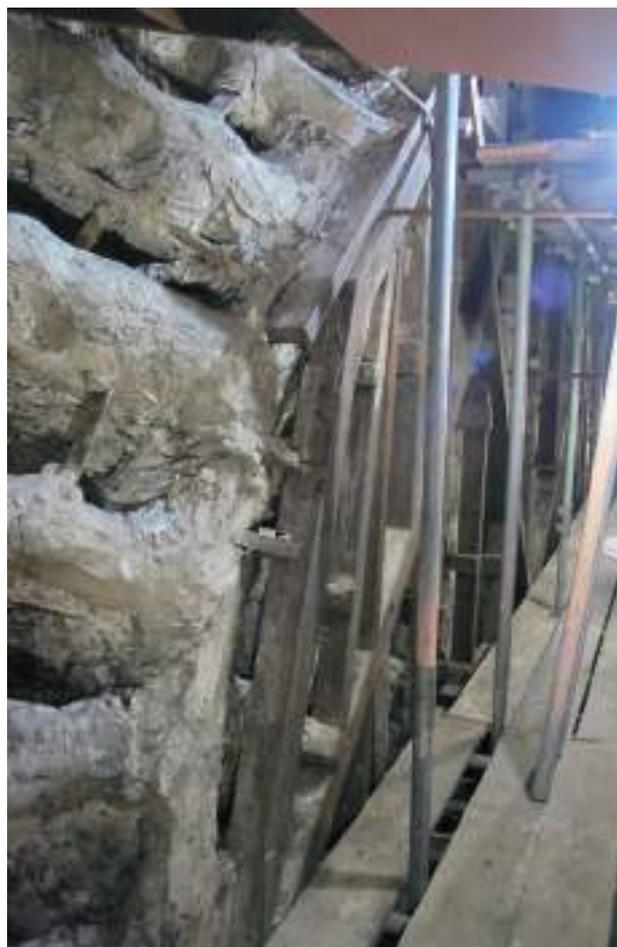
**Figura 7.** Estructura posterior del tímpano y la arquivolta de los ancianos tras su restauración.
