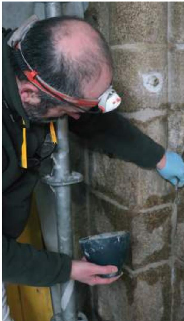
**Figura 19.** Proceso de rejuntado en la contrafachada norte.
