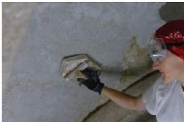
**Figura 11.** Proceso de fratasado de los revocos de reintegración en plementos.
