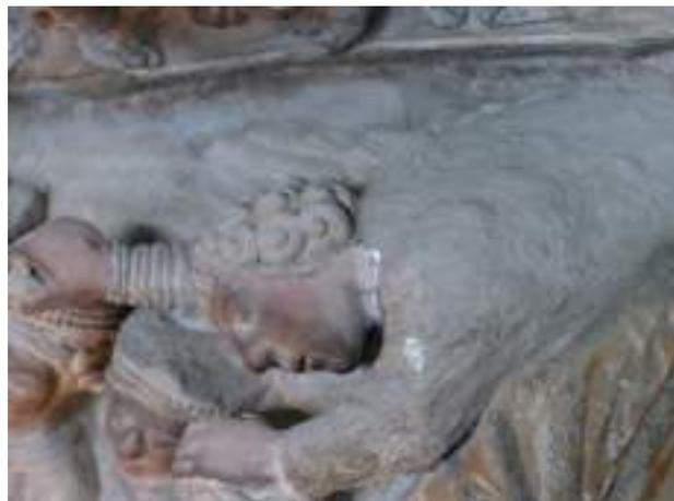
**Figura 7.** Reintegración de yeso y cemento.
