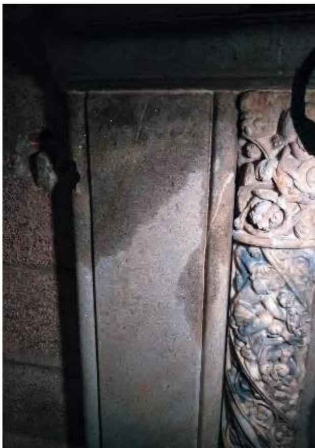
Figura 15. Condensación en la zona baja del nártex.
