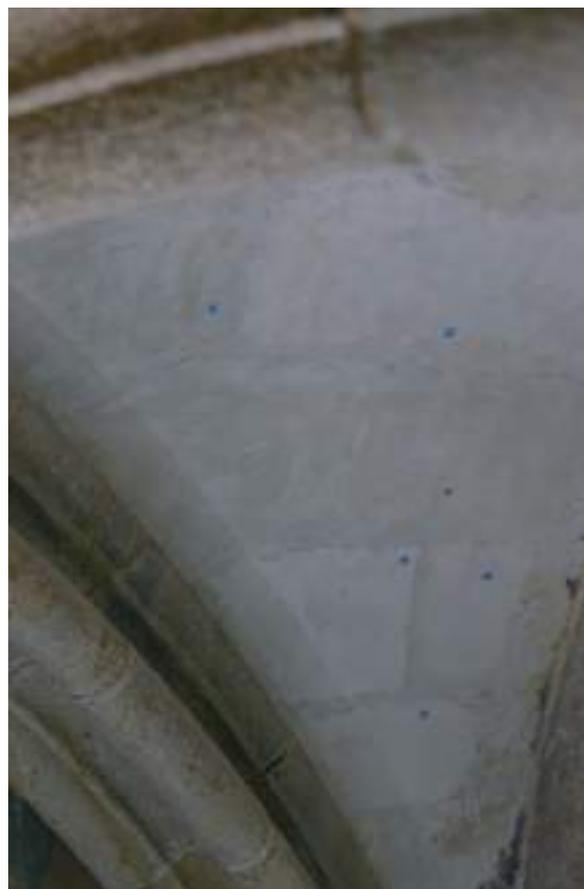
Figura 3. Pruebas con diferentes áridos para reponer el enlucido de los plementos.
