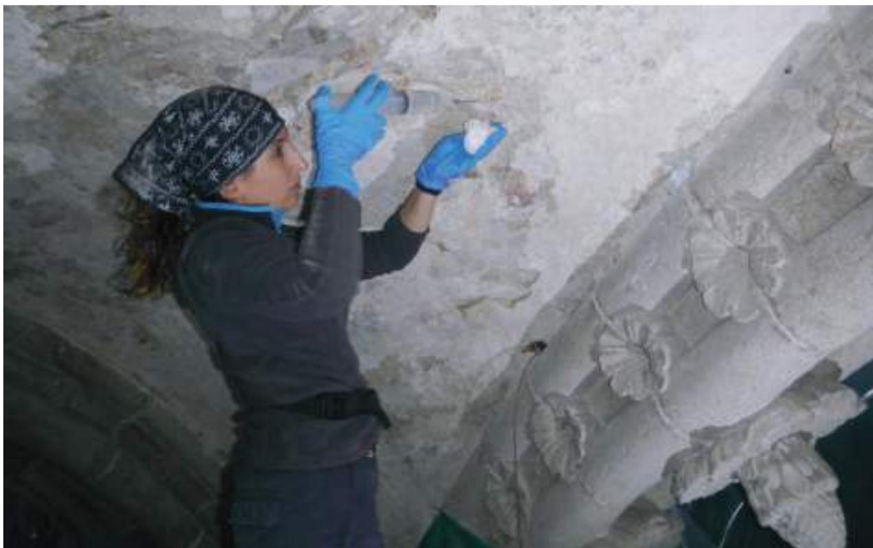
**Figura 7.** Consolidación de los revocos de las bóvedas. Proceso de inyección.
