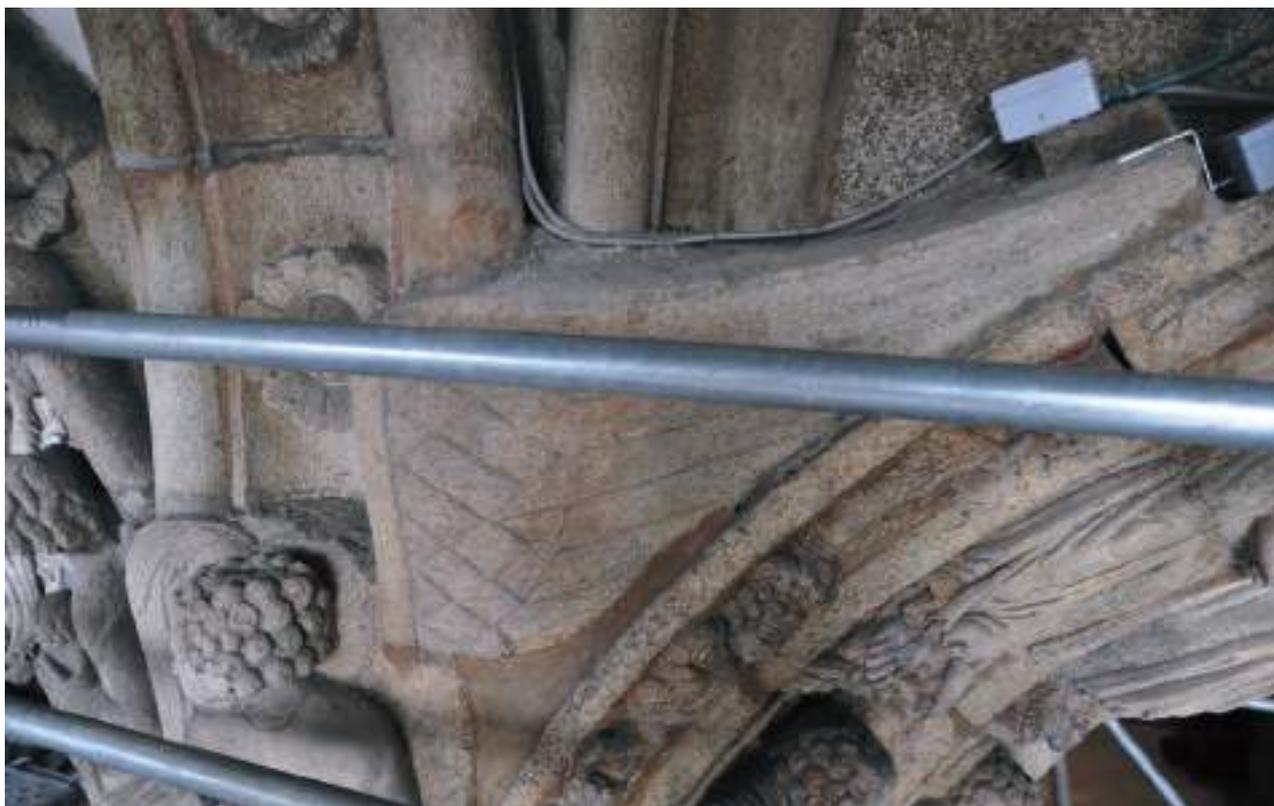
**Figura 16.** Catedral de Santiago de Compostela. Pórtico de la Gloria. Encuentro entre la arquivolta sur y el arco fajón, detalle.
