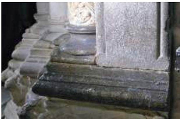
**Figura 7.** Aplicación de gel de Agar. Zona PT3, basamento.
