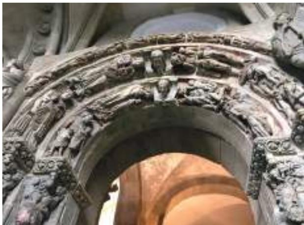
**Figura 6.** Vista parcial tras la eliminación de las reintegraciones.
