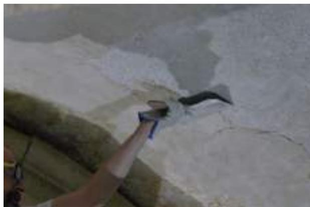
**Figura 12.** Aplicación de estuco rascado en bóvedas.
