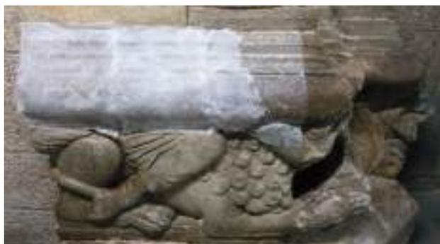
**Figura 23.** Primera extracción-aplicación de Carbogel en el basamento y un capitel. Zona PT3 JB03.
