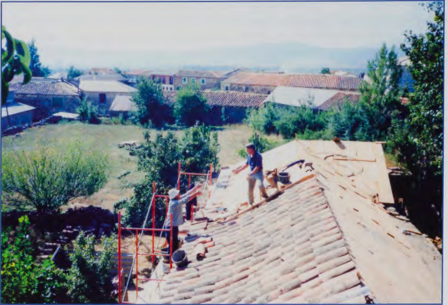
Transferencia de una teja, Armando y Ken / Tile transfer....
