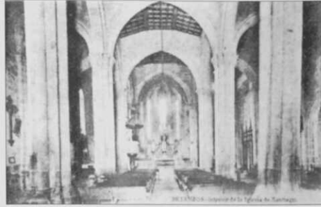
Fig. 12.- Interior de la iglesia de Santiago. Obsérvese la acusada inclinación de los pilares, disposición ésta que también se advierte en Santa María "do Azougue", aunque aquí el desplome de las columnas es menos acentuado. Las opiniones de los doctos, en cuanto a los problemas que plantean tales deformaciones arquitectónicas, como en el caso de la ex-colegiata de Sar, son muy diversas
