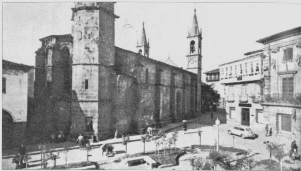
Fig. 10.- Iglesia de Santiago (siglo XV) y torre municipal (siglo XVI).
