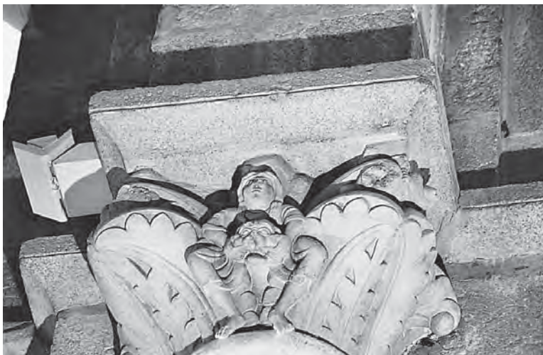
Fig. 17. Catedral de Santiago, pórtico interno de la fachada sur, capitel.
