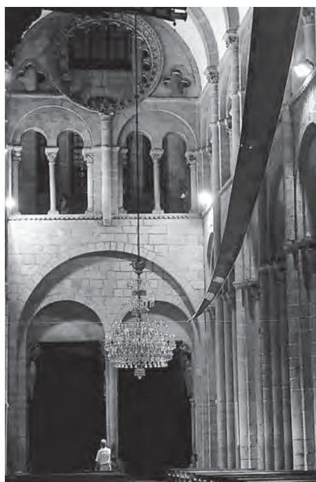
Fig. 4. Cierre de la nave mayor de la catedral. En el parteluz del Pórtico de la Gloria se apoyan los arcos de descarga de los dinteles; más arriba, el arco del tímpano, triforio, el gran óculo y vanos laterales. En la nave está colgado el gallardete de la batalla de Lepanto. (Archivo Yzquierdo).
