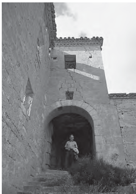
Fig. 14. Camino Jacobeo del Ebro. Detalle del estado actual de la Venta y Ermita de la Magdalena a orillas del Ebro (actual embalse de Mequinenza) entre Caspe y Mequinenza (pórtico de acceso).
