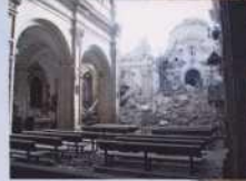
Parroquia de Santiago de Lorca después del Terremoto
