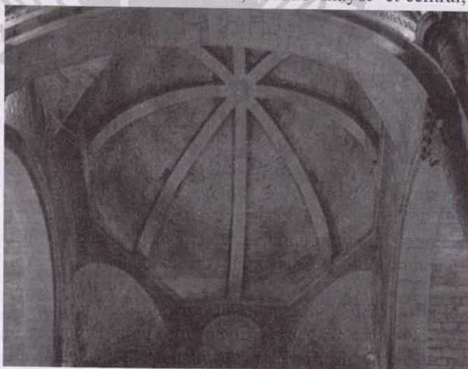
Cúpula reforzada por arcos en la catedral de Jaca
