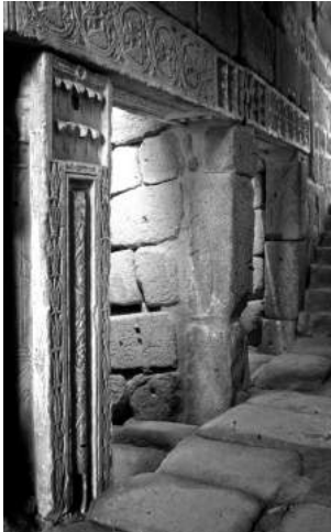
Figura 7. Pilastras cristianas de época visigoda reutilizadas en una construcción militar islámica (s. IX).
