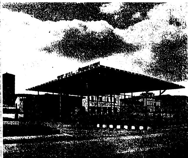
Estación de servicio de Castildelgado.
