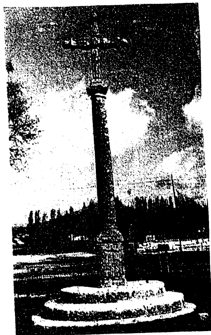
Hospital del Rey. — Crucero.
