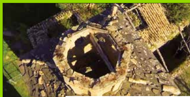
Vista aérea de la torre de la iglesia de Ruesta
