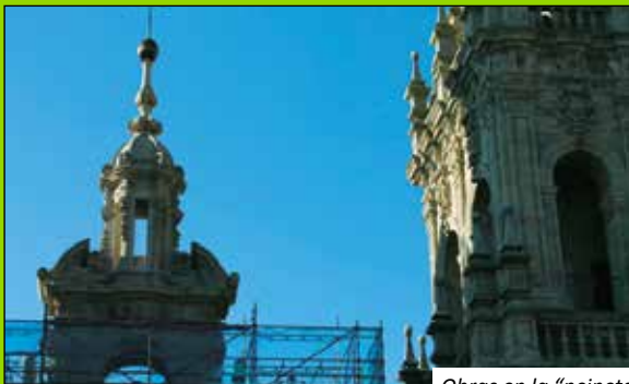
Obras en la "peineta"
