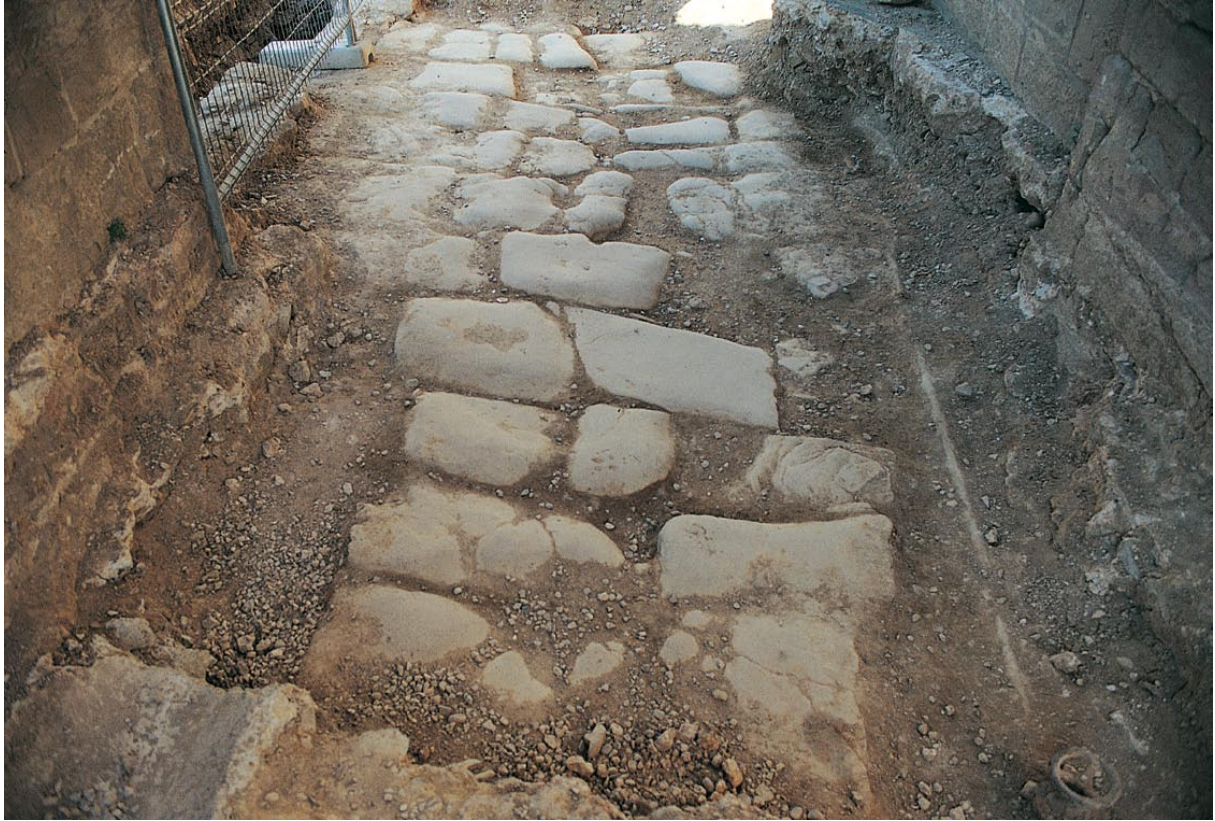
Puente la Reina: pavimento original del puente románico, constituido por losas de arenisca, que fue encontrado durante las excavaciones de 1999 (Fotografía de Javier Armendáriz)
