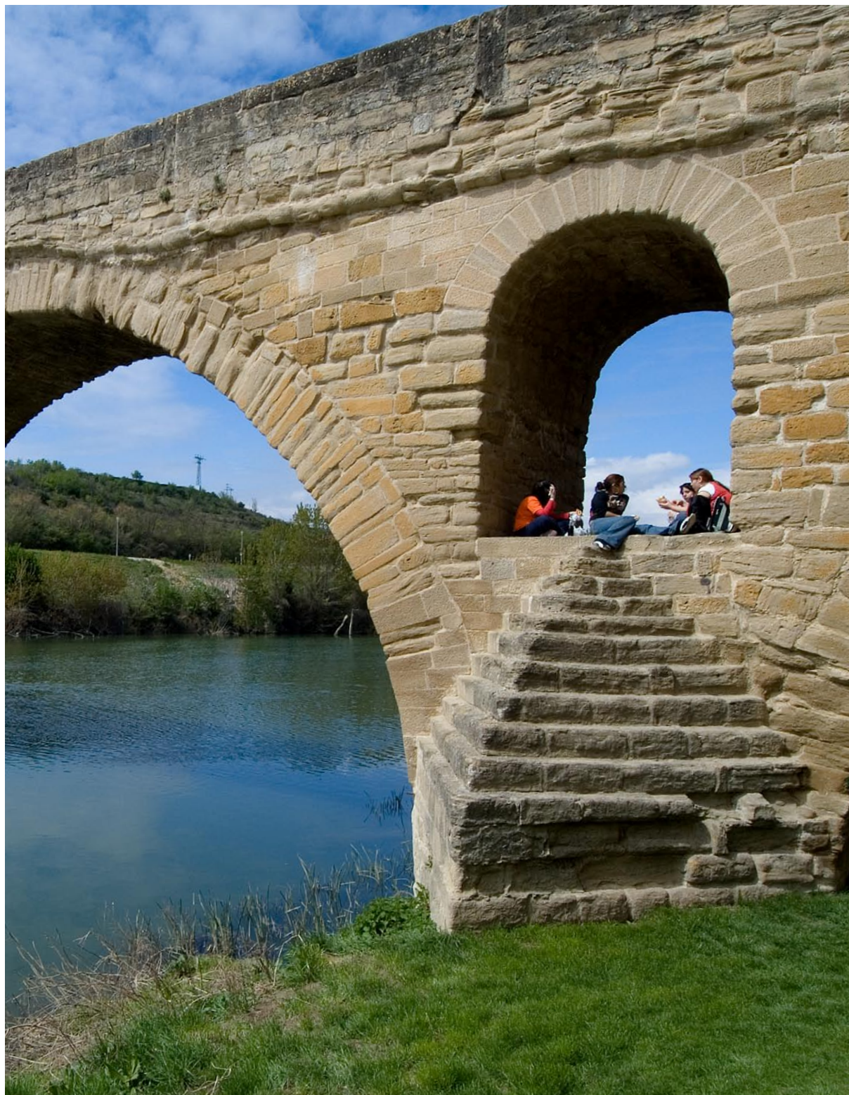
Detalle de tajamar, aliviadero y aparejo del puente de Puente la Reina
