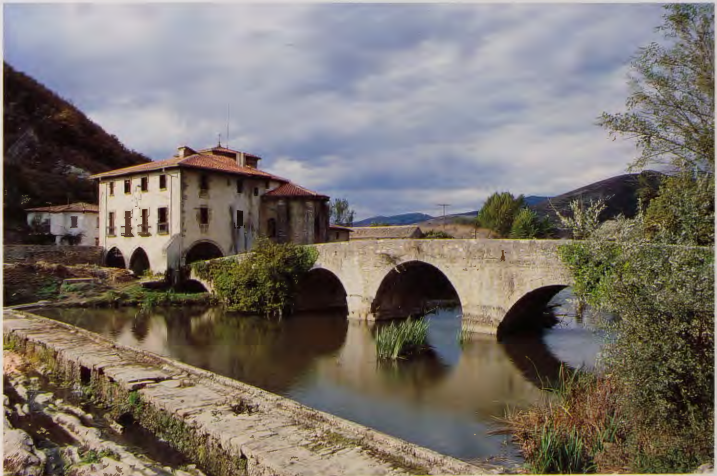
9.8. Conjunto de la Trinidad de Arre (Navarra). En primer plano, presa para derivar agua a los molinos, en segundo, el puente romanomedieval y, al fondo, el ábside de la iglesia románica.
