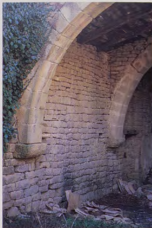
9.6. Detalle de los dos arcos fajones del hospital de Catalain que subsisten.
