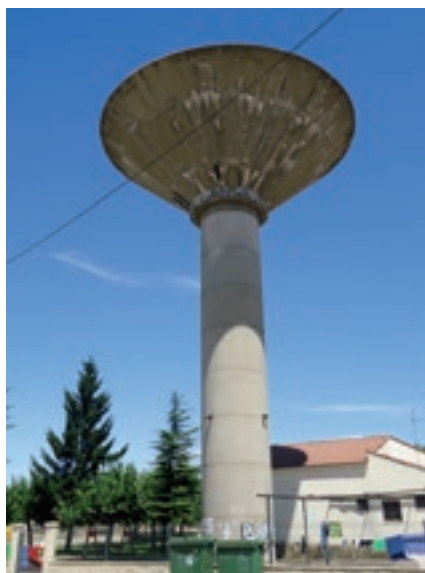
Depósito de agua en San Martín del Camino.
