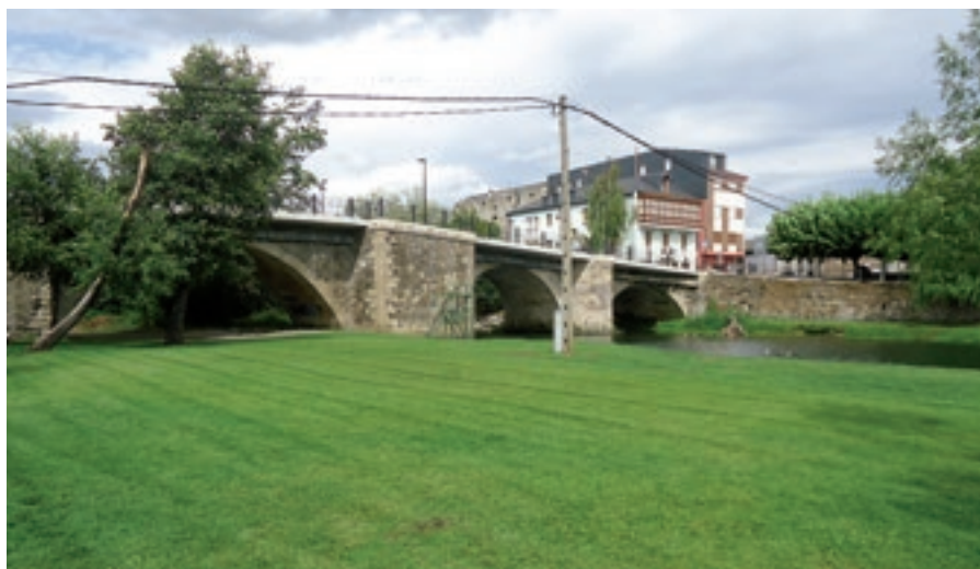
Puente Mayor sobre el Río Cúa en Cacabelos.
