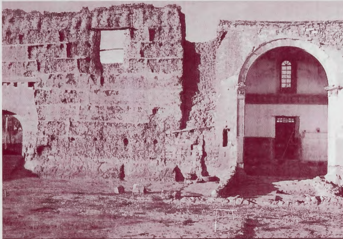
Puente, murallas, templos y convento de San Agustín son los únicos testigos mudos de los sucesos de la Guerra de la Independencia en Mansilla. Ruinas del convento antes de la rehabilitación. (Foto gentileza J. Celis)
