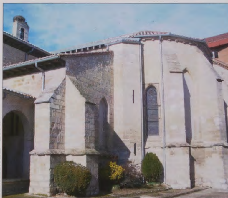
Abside del templo. Convento de Santa Clara.
