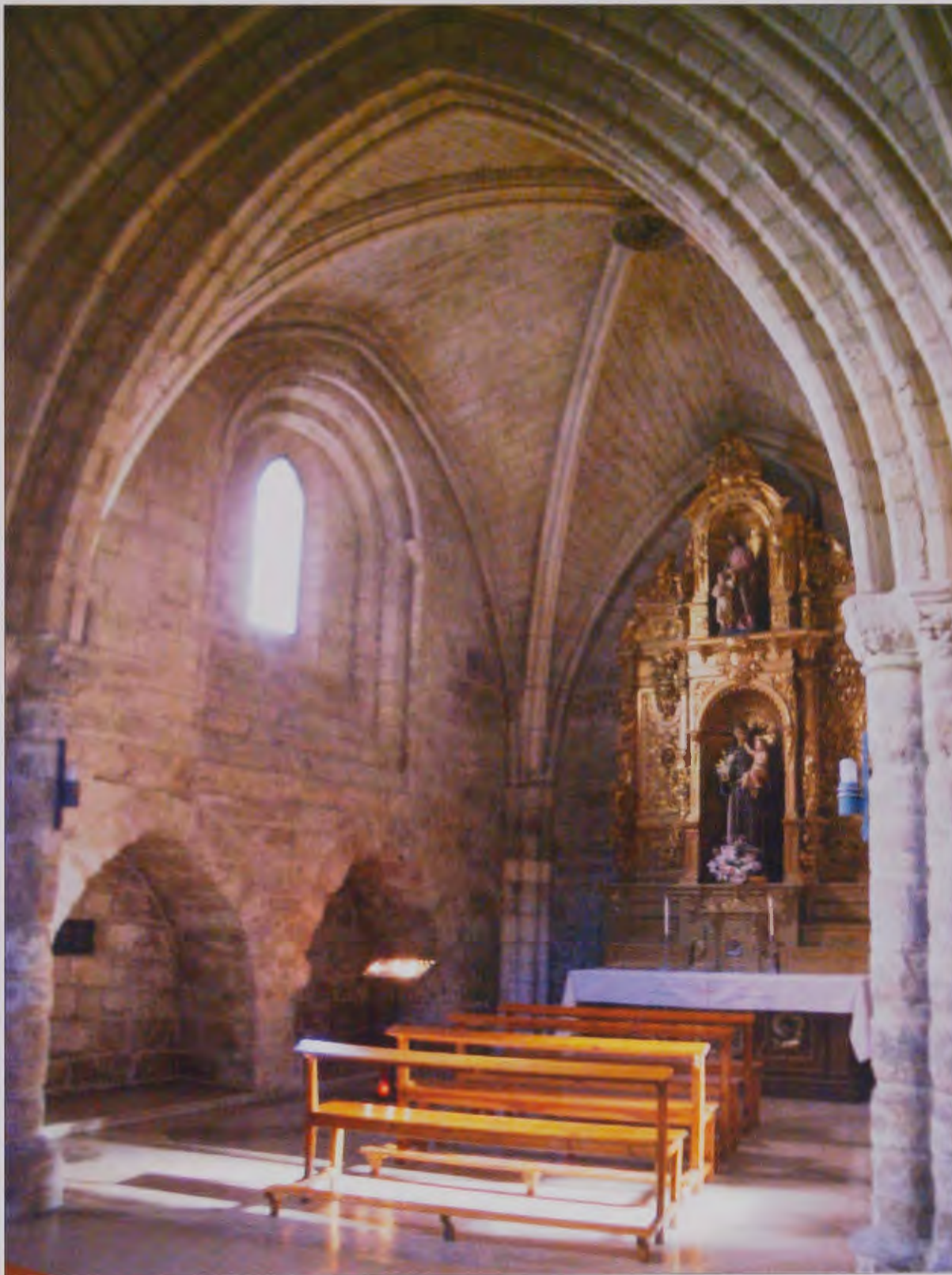
Capilla Lateral. IGLESIA DEL CONVENTO DE SANTA CLARA
