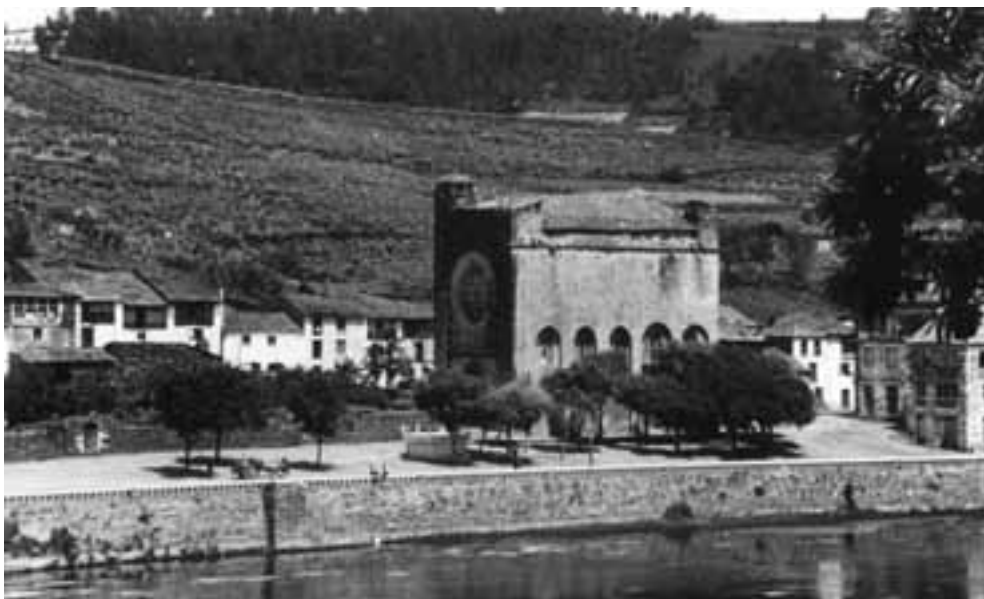
Fig. 11. Emplazamiento de la iglesia de San Xoán en el conjunto medieval de Portomarín (ca. 1955. APS).
