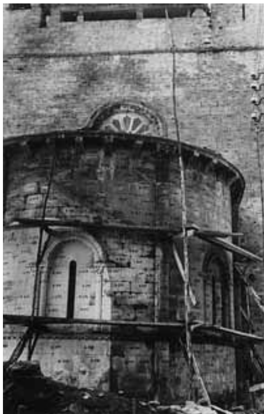
Fig. 5. Numeración de sillares de la iglesia de San Xoán en el conjunto medieval de Portomarín (ca. 1960. APS).
