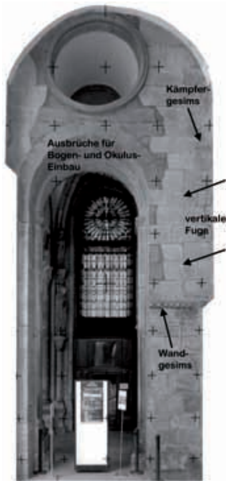
Fig. 12. Tramo W11N1d. Nave lateral norte. Fotogrametría desde el este documentando los vestigios de las primeras fases constructivas (BTU Cottbus 2004).
