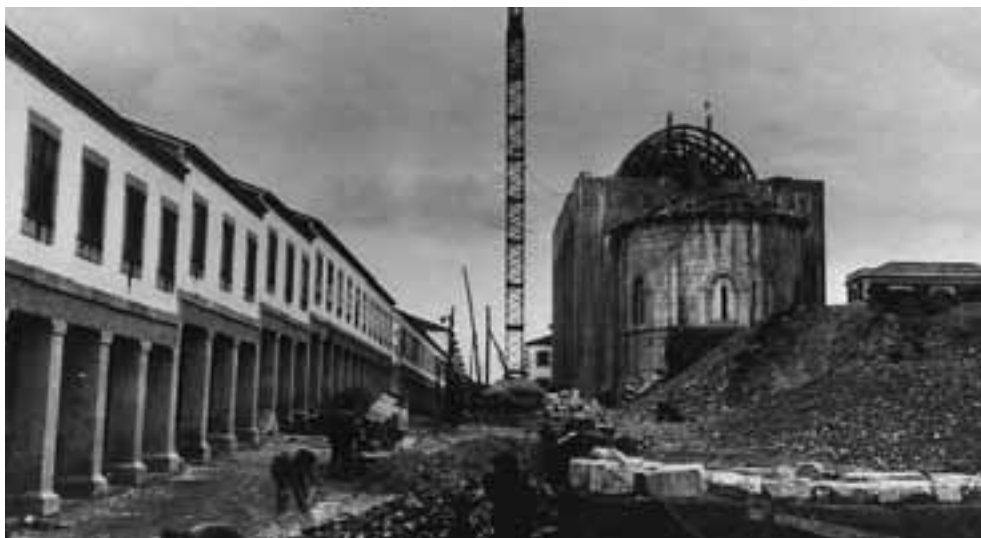
Fig. 12. Reconstrucción de la iglesia de San Xoán en el nuevo Portomarín (ca. 1960. APS).
