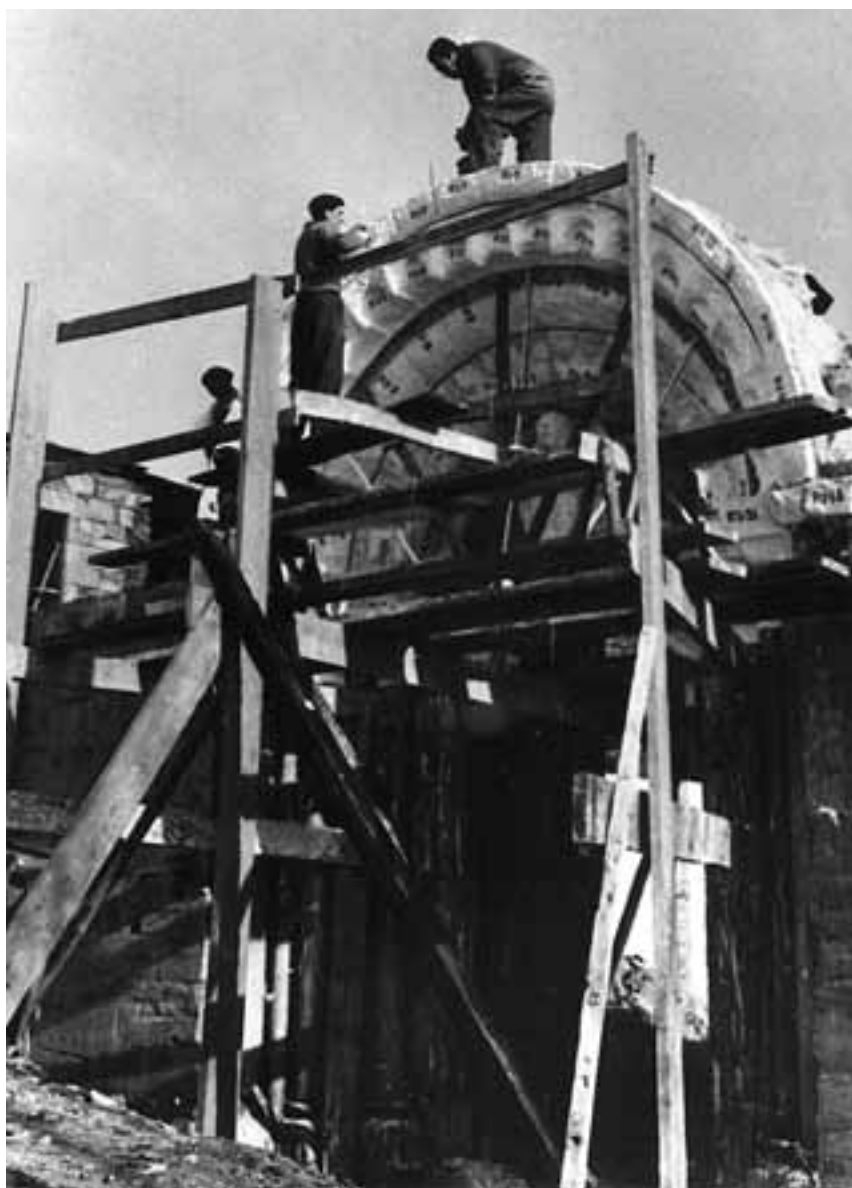
Fig. 6. Desmontaje de la iglesia de San Xoán en el conjunto medieval de Portomarín (ca. 1960. APS).
