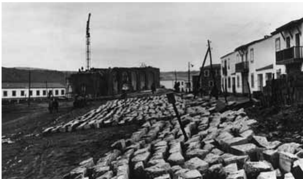
Fig. 7. Desmontaje y clasificación de piezas de la iglesia de San Xoán (ca. 1960. APS).
