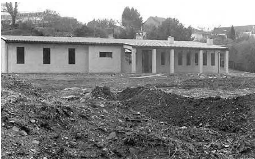
Albergue de en construción Foto: Carlos
