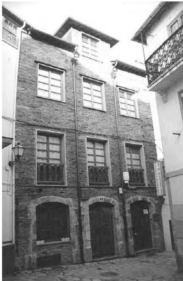
Casa remozada del Hospital de Apostol Santiago y Sta. María Magdalena de Navia. Foto: A. B. de los Toyos de Castro
