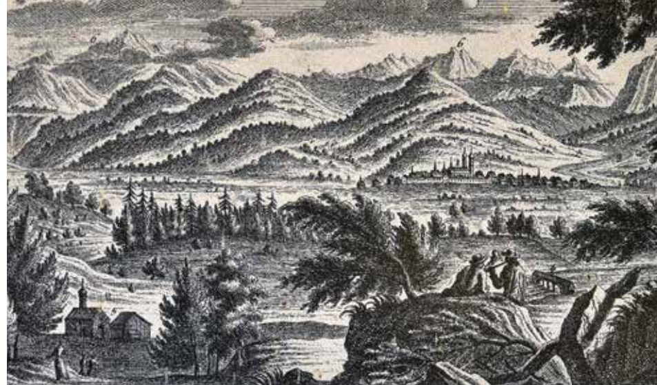
Chapelle et auberge sur le col de l'Etzel avec le pont du diable et le monastère d'Einsiedeln. Reproduction gravée au cuivre sur le panneau d'information du col de l'Etzel
