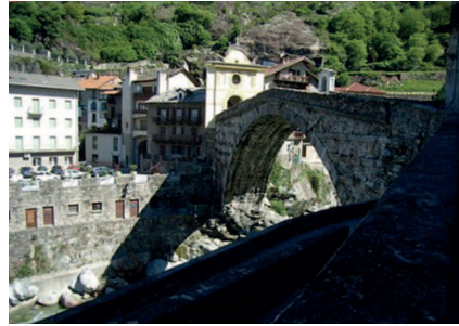
Brücke über die Lys-Schlucht in Pont-St-Martin
