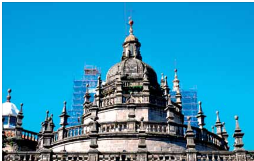
Los andamios acechando al cimborrio. M o Formento
