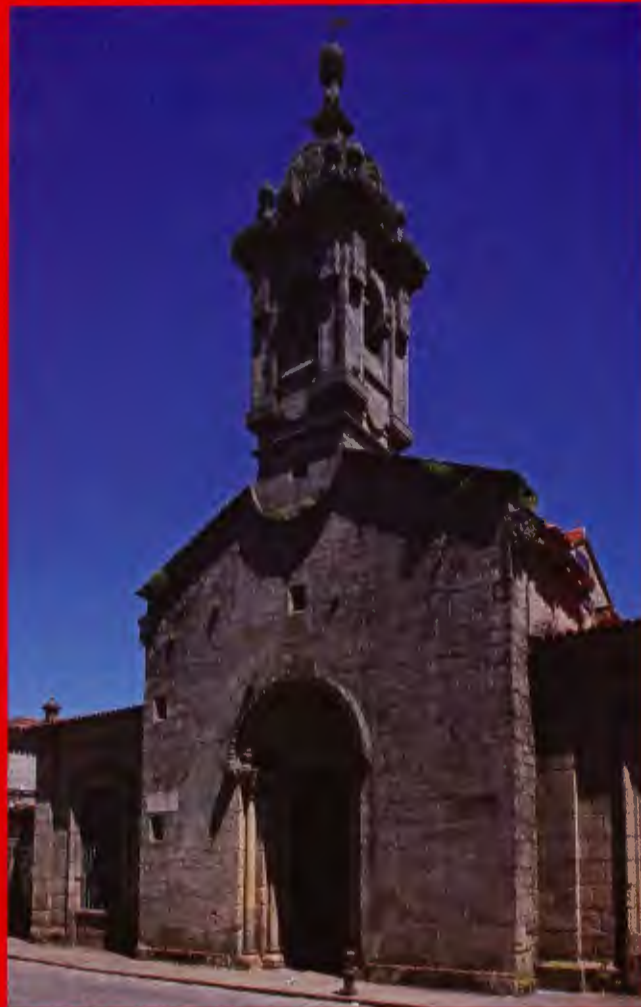
Fachada de la iglesia de San Fiz de Solovio
