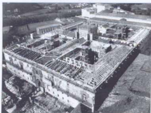
Fig. 7: MORENO, CANO, GÓMEZ y DE LA JOYA. Transformación en hotel del Hospital Real (1954). Obras.
