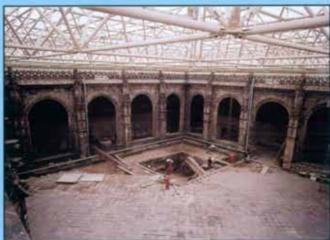
Excavaciones en el patio del claustro (1991-92). Foto: G. Gil
