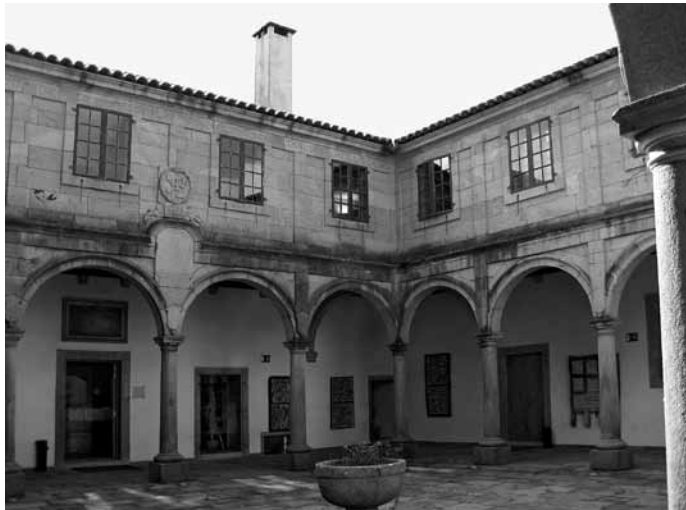
Fig. 5 Patio hospital de San Roque, Santiago de Compostela
