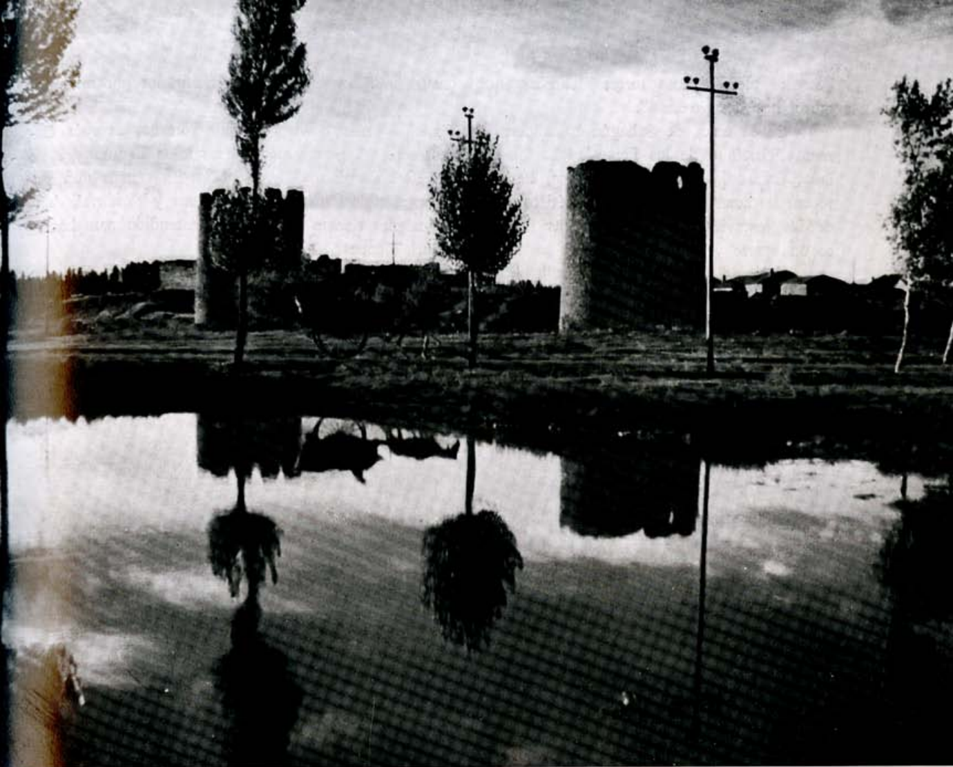
MANSILLA.—Muralla del Oeste
