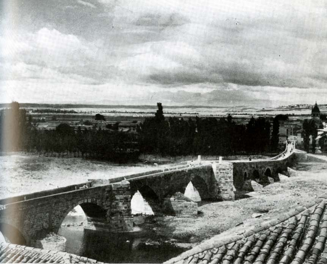
HOSPITAL DE ÓRBIGO.—Puente del «Paso Honroso»
