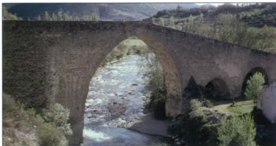
El puente de San Miguel en Jaca (Huesca), restaurado por Fisac en 1943
