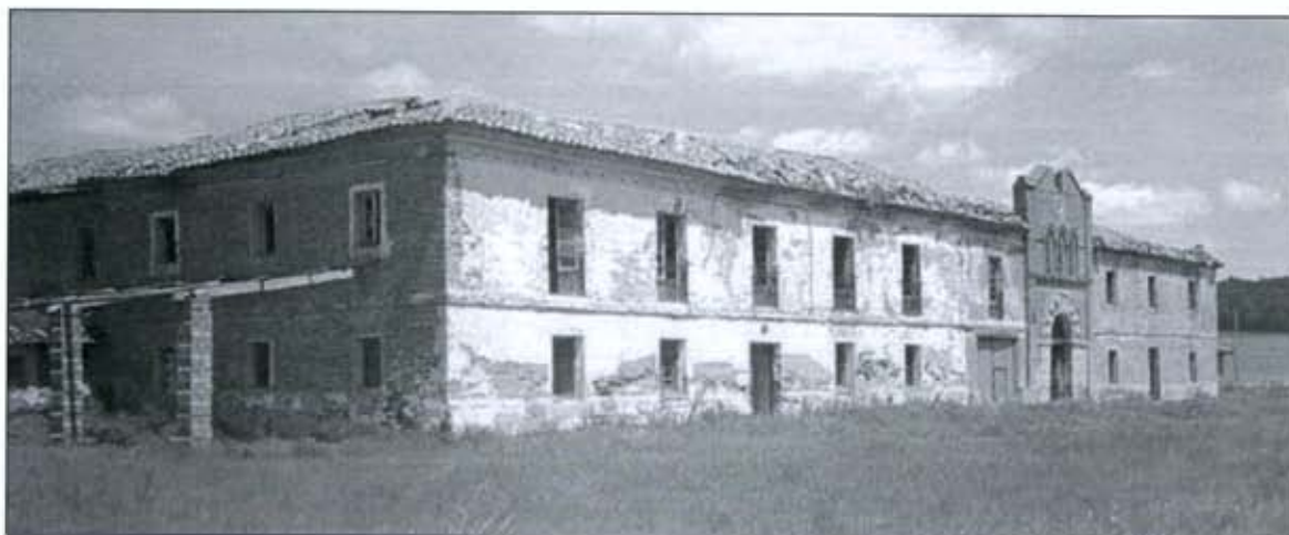
Imagen del conjunto de Santa María de las Tiendas, antes de su demolición
