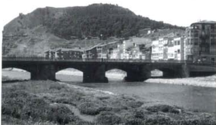
Puente actual sobre el río Najerilla.
