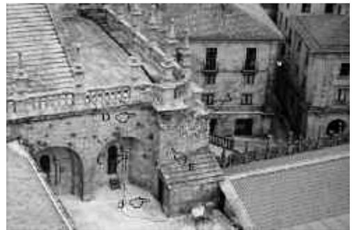
Fig. 12. Detalle del ángulo oeste de la fachada de las Platerías. A- Contrafuerte exterior sobre el que se apoya el Pasadizo del Tesoro, B- Caja de las antiguas escaleras al Tesoro, C- Restos de la torrecilla circular románica, D- Arranque de la Torre del Ángel, E- Contrafuerte de la Torre del Ángel.
