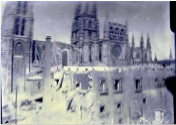
Una de las pocas imágenes que existen del derribo del Palacio Arzobispal.
