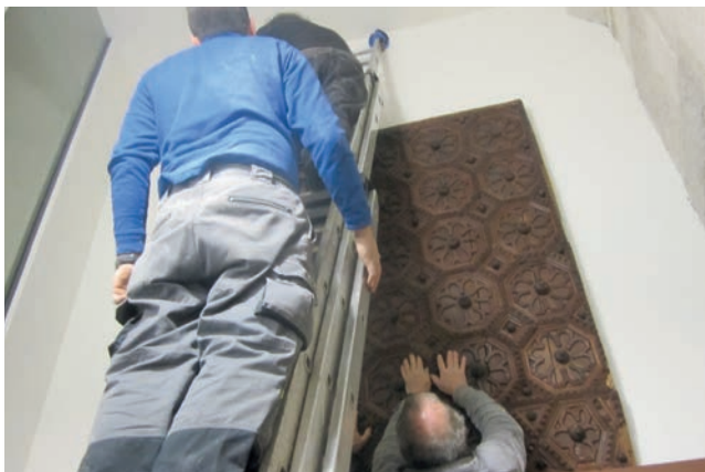
Un momento de los trabajos de colocación del artesanado.
