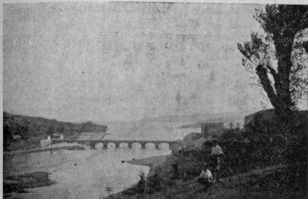
N.º 6.—San Vicente de la Barquera. Puente sobre la ría.
