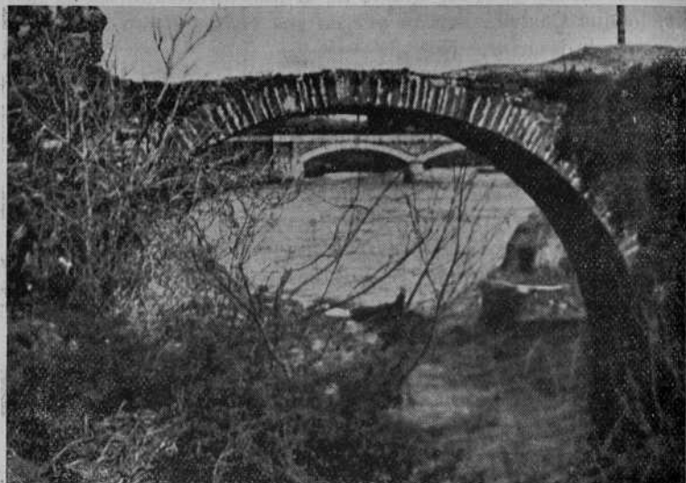
N.º 9.—Puerto Marín. Detalle del Puente Viejo.
