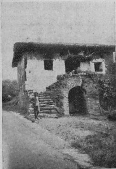
N.º 2.—Miravalles. Casa vasca.
