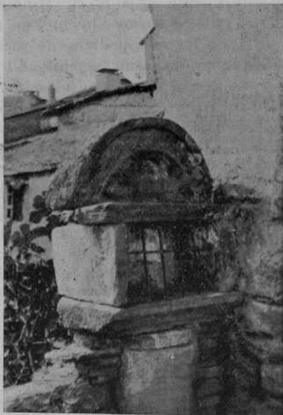
N.º 10.—Puerto Marín. Petitorio en el Puente Viejo.
