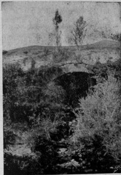
N.º 8.—Galarreta. Puente del camino.
