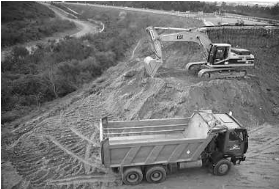
Lavacolla: Camiño e obras da autovía
