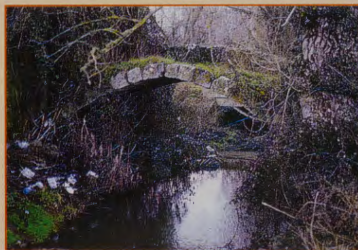
Puente de "La Viñuela" en Santovenia, antes de su restauración.
