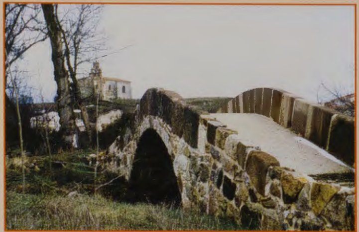
Puente de "La Viñuela" en Santovenia, en su estado actual.
