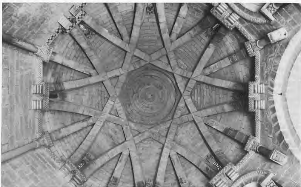
Fig. 9. Bóveda de nervios de entrecruzamiento periférico en el Santo Sepulcro de Torres del Río.
