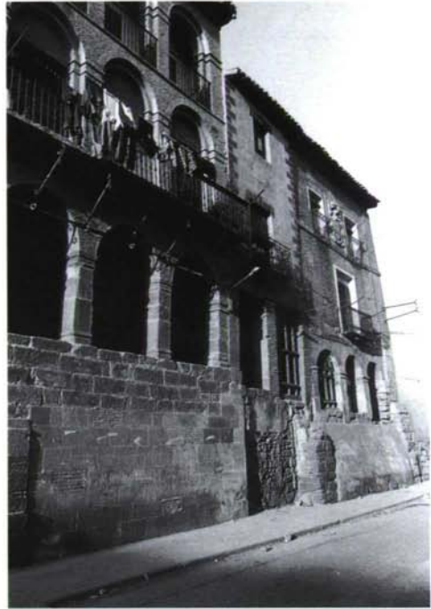
Lámina 3. NAVARRETE. Calle de la Cruz: restos del recinto amurallado. Foto. J. Passini 1979.
