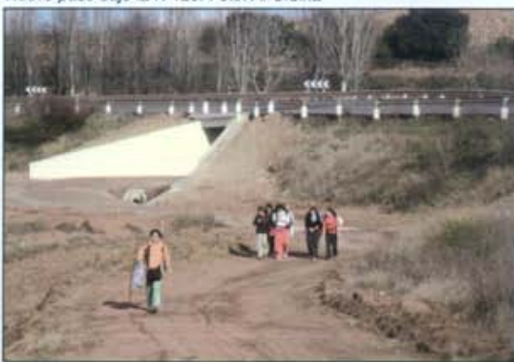
Nuevo paso bajo la N-120. Foto: A. Urbina
