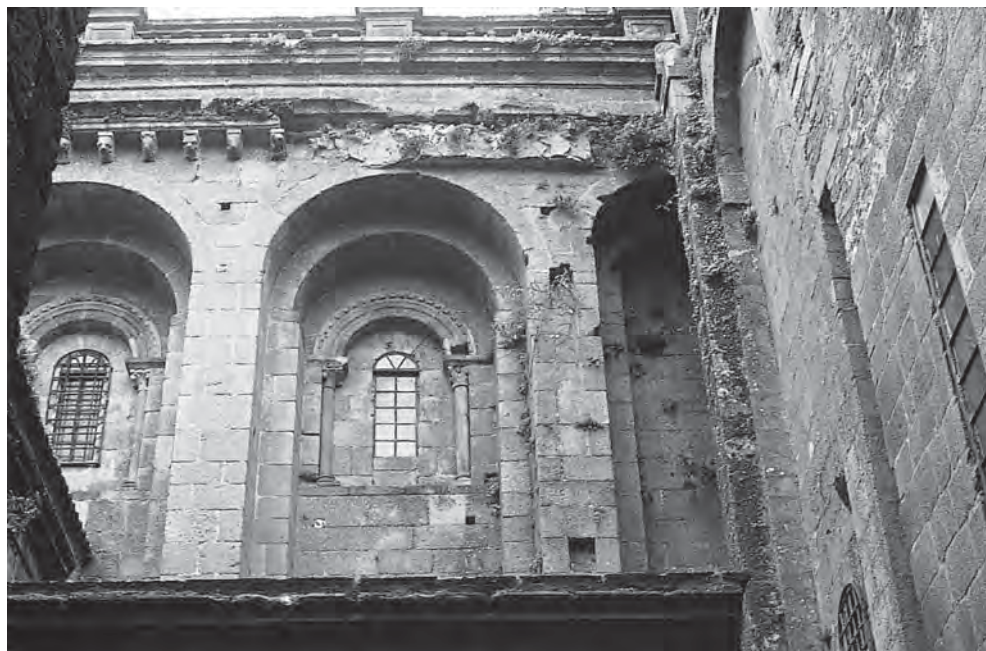
Fig. 3. Últimos tramos del muro norte de la catedral en cuyos canecillos intervino el taller del maestro Mateo. A la derecha muro de la torre medieval, hoy Torre de la Carraca. (Archivo Yzquierdo).
